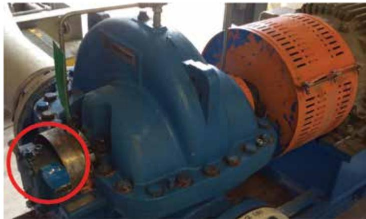
Рисунок 18. Насос двойного всасывания с горизонтальным разъемом корпуса; монтаж на корпус упорного подшипника
