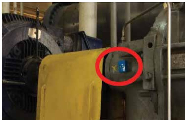
Рисунок 21. Вакуумный насос; боковой монтаж на корпус подшипника
