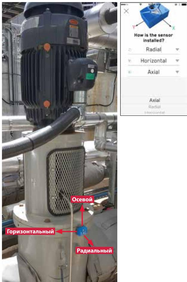
Рисунок 34. Стандартная ориентация на вертикальном насосе
