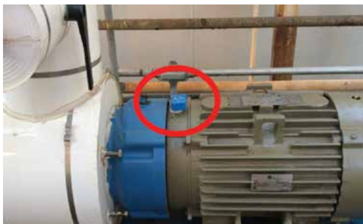
図 16: 駆動側のベアリングハウジング上に取り付けられた強連結モーター
