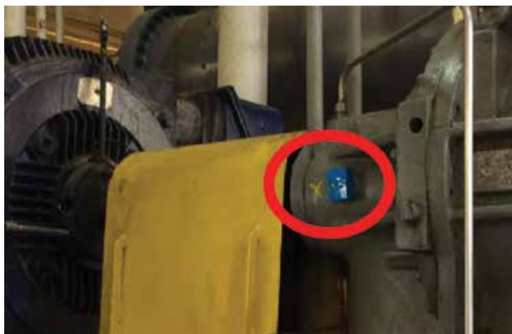
図 21: ベアリングのハウジングの横に取り付けた真空ポンプ
