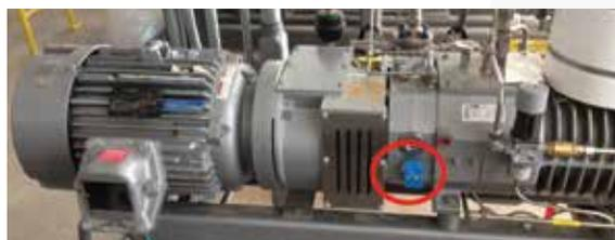
Figura 13: Bomba PD, montaje lateral
