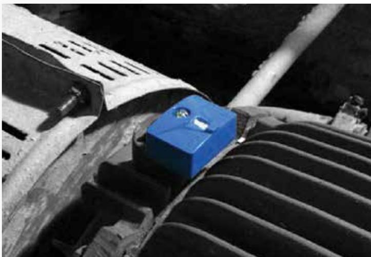
Figura 15: Motor horizontal, instalado en la carcasa de rodamiento de extremo con motor
