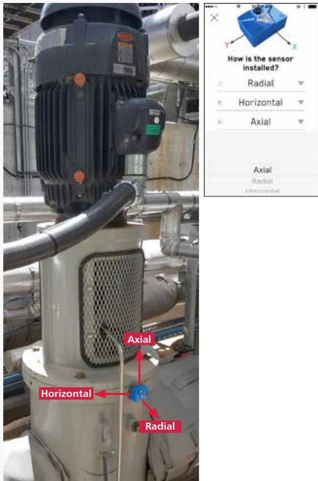
Figura 34: Orientación estándar en una bomba vertical
