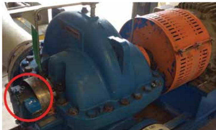
Figura 18: Succión doble, bomba de carcasa partida horizontal, instalación en la carcasa de rodamiento de propulsión
